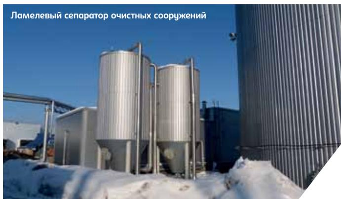
Ламельный сепаратор очистных сооружений
